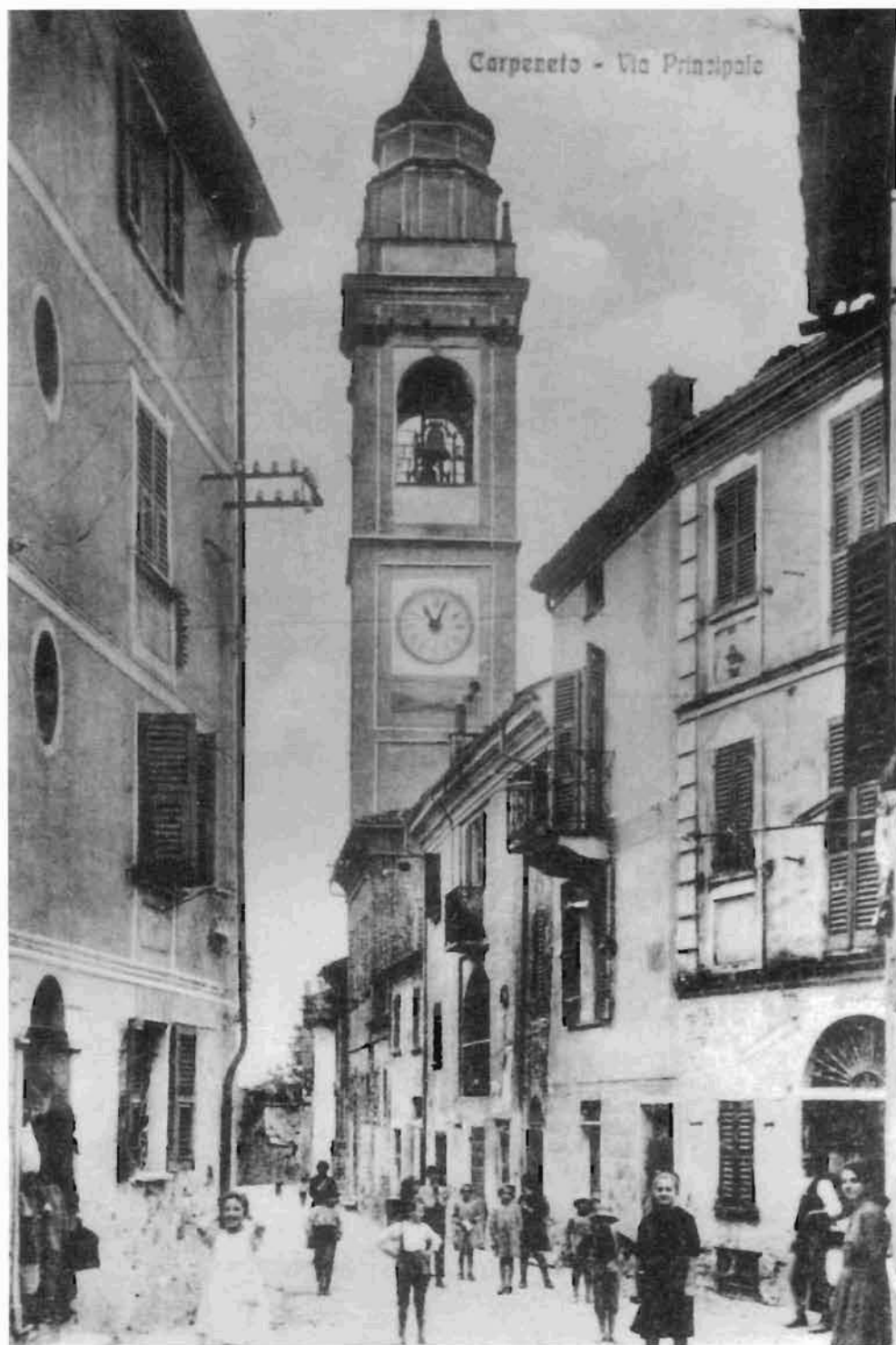
Via Principale attuale Corso Torino
