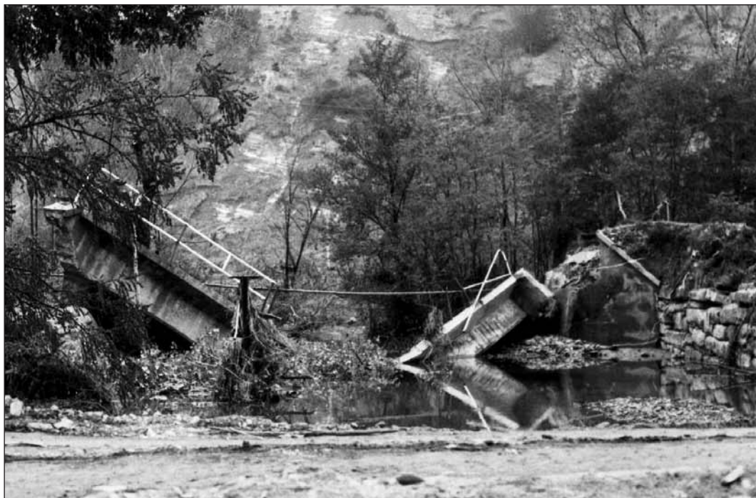
1977: il ponte crollato in località Panicata in territorio del Comune di Belforte Monferrato
