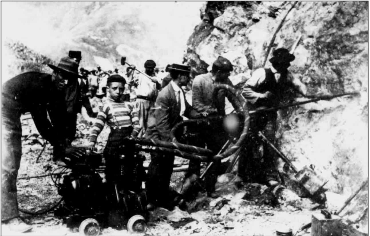
I componenti del gruppo, non in tenuta da lavoro, posano per il fotografo a ricordo dell'inizio dei lavori di sbancamento per la costruzione della diga "lago della Lavagnina". Il fioretto collegato al compressore prepara i fori nella dura roccia per le cariche di dinamite.
