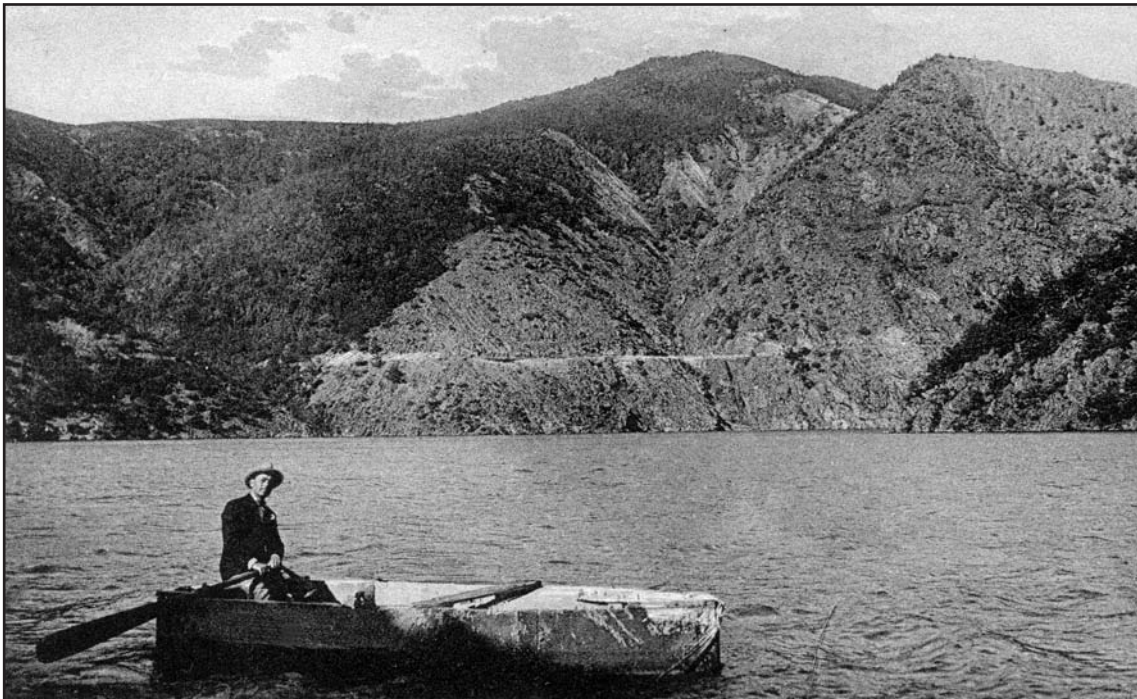
In posa per il fotografo sul Lago della Lavagnina il signor Tranquillo, dipendente della ditta appaltatrice dei lavori per la costruzione della diga.
