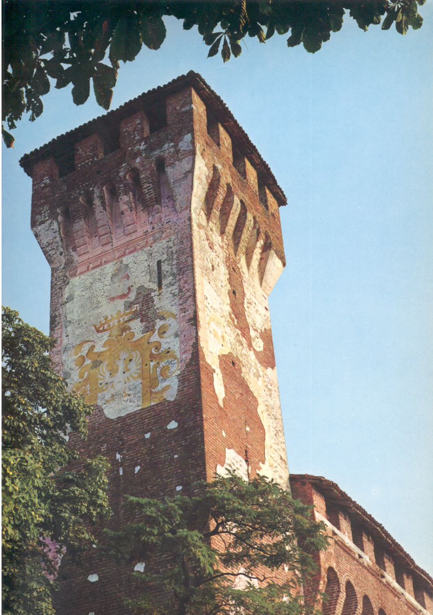
SAN CRISTOFORO - Torre del Castello.
