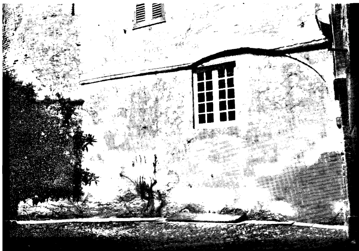
Cortile interno, particolare del tamponamento di un'arcata preesistente.
