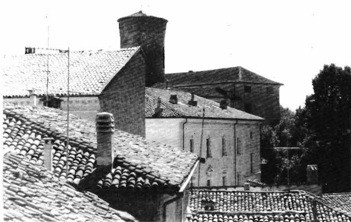
Veduta del castello con l'antistante Palazzo Borgatta in corso di restauri
