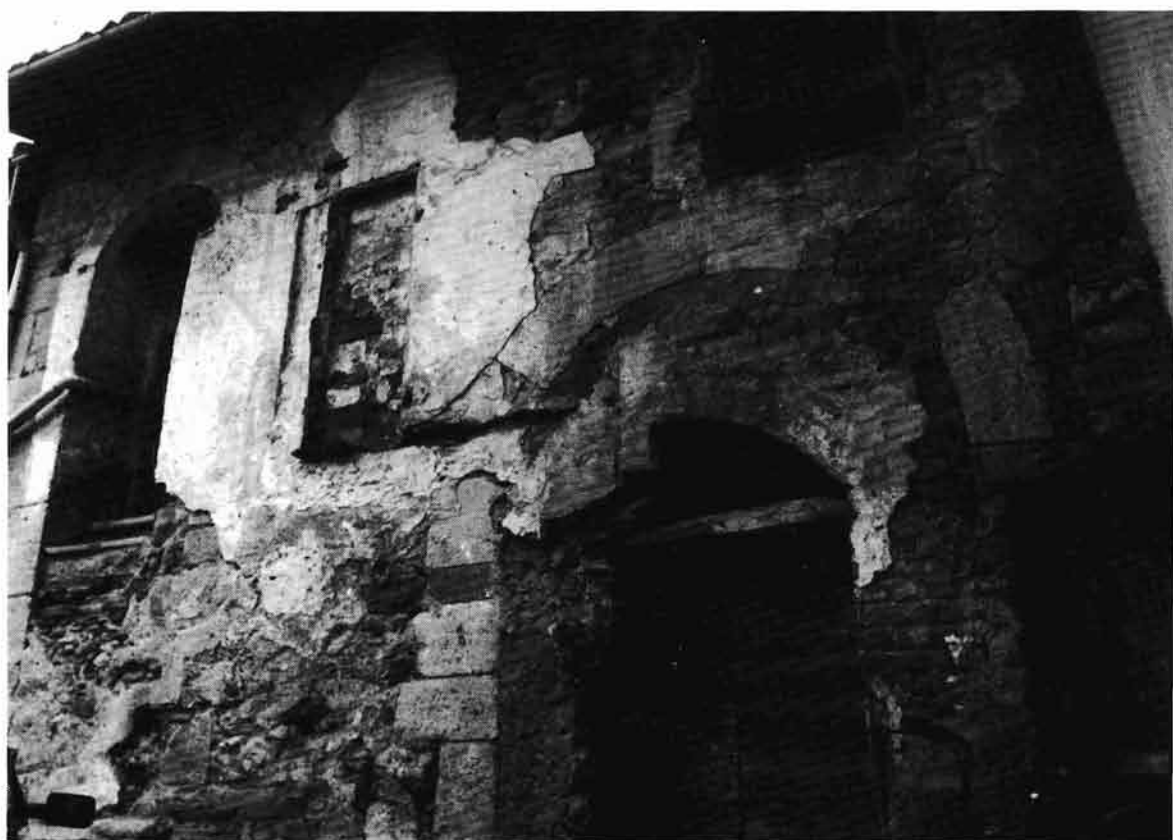
Casa del cortile di via Borghetto n°58. Le tracce risalenti al secolo XV consistenti in un arco, una colonna e parti di muratura in pietra scura sono inglobati nella costruzione attuale di epoca successiva e fortemente degradata.
