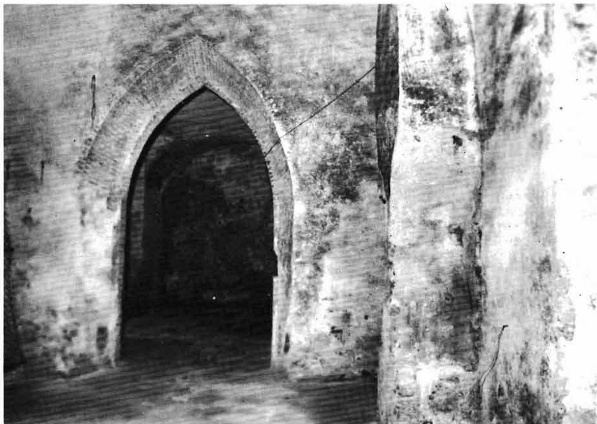
Cantine: varco di comunicazione tra due ambienti, interessante la soluzione dell'arco a sesto acuto sottolineato dall'uso del mattone a vista.
