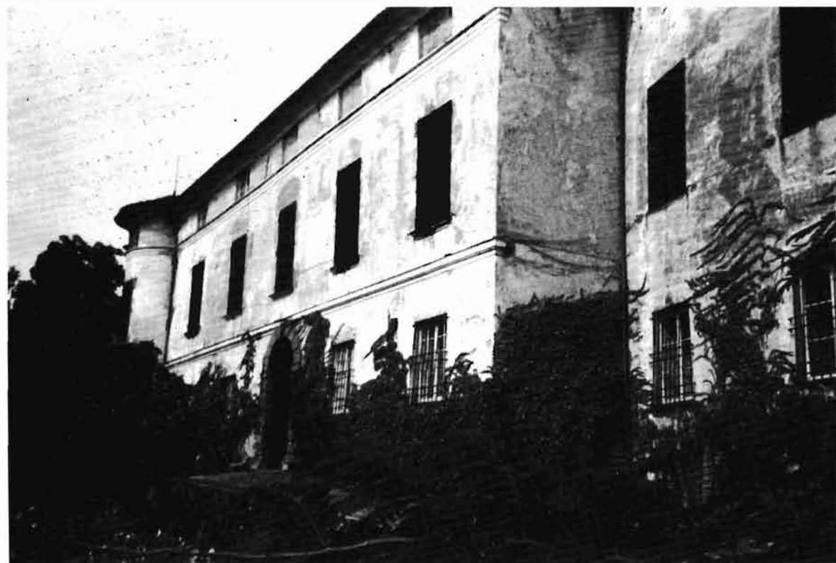
Prospetto sud-est con ingresso al cortile interno, emerge la mole cinquecentesca successivamente modificata negli ampliamenti del XVIII.
