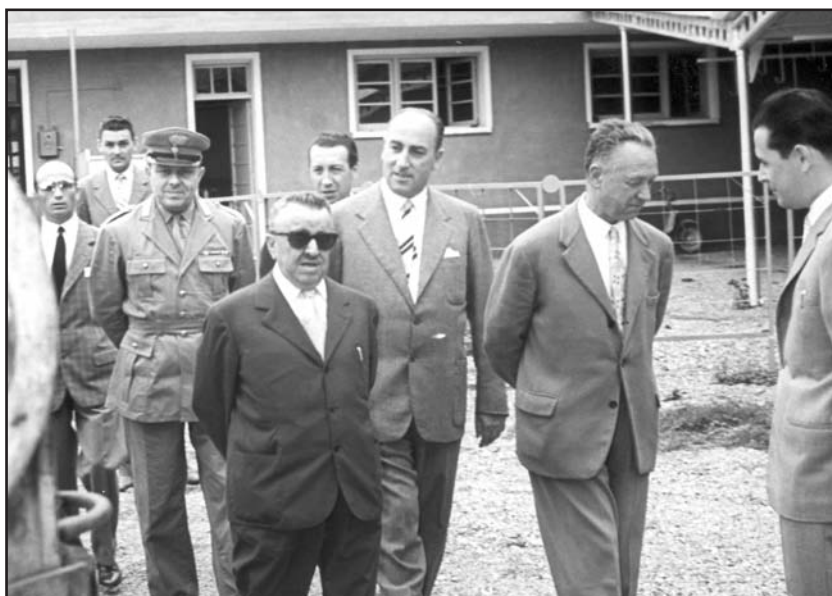
In alto, momenti della costruzione dello stabilimento ORMIG Sopra, da sinistra: il Maresciallo Pino, il Ministro Romita, Guido Testore, mio padre e il Sig. Colla
