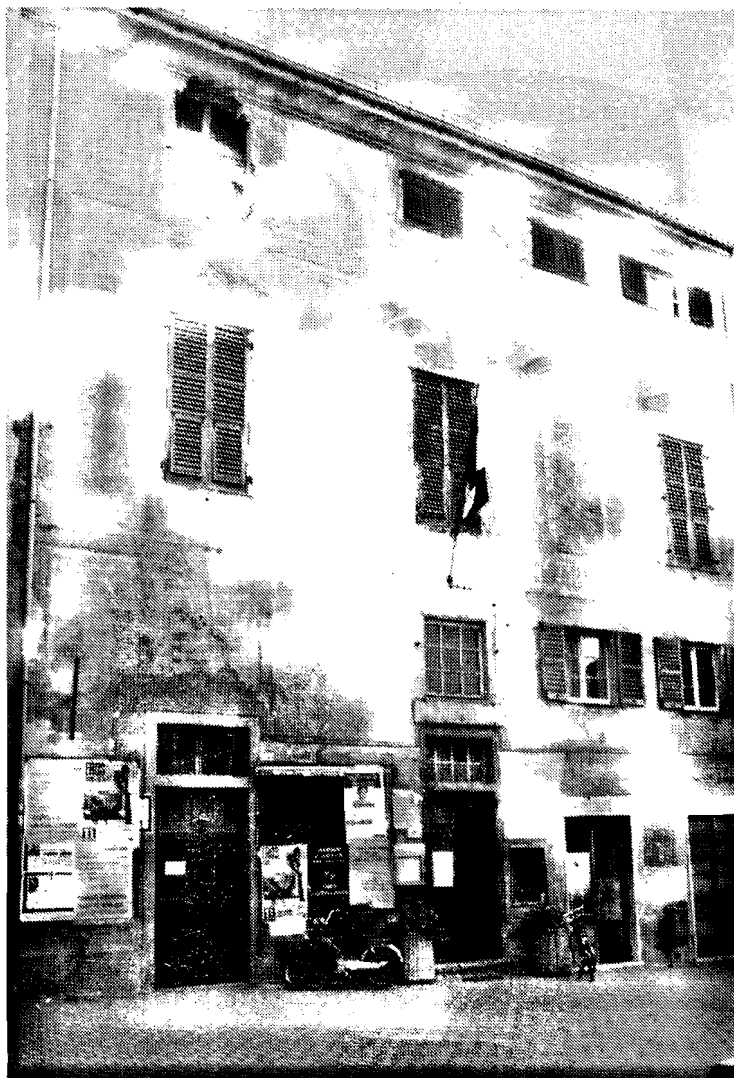
CERESETO. Il prospetto del palazzo Spinola, deteriorato e deturpato dagli affissi.
