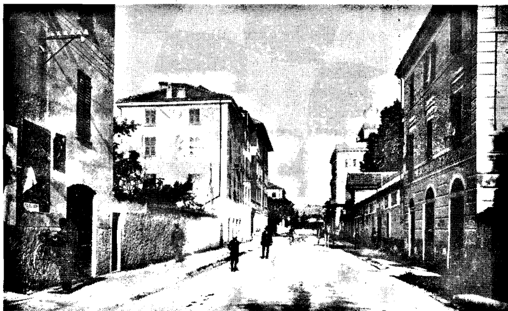
TORINO. Il corso agli inizi del secolo quando ancora era intitolato a Vittorio Emanuele II.
