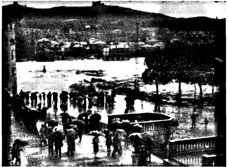
CASTELLO. La piazza sconvolta dopo il disastro della diga di Molare (13.8.1935).
