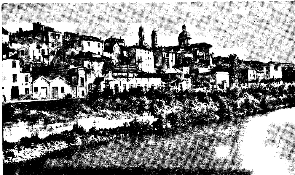
LUNGORBA MAZZINI. Veduta della via, realizzata nell'autunno del 1899.
