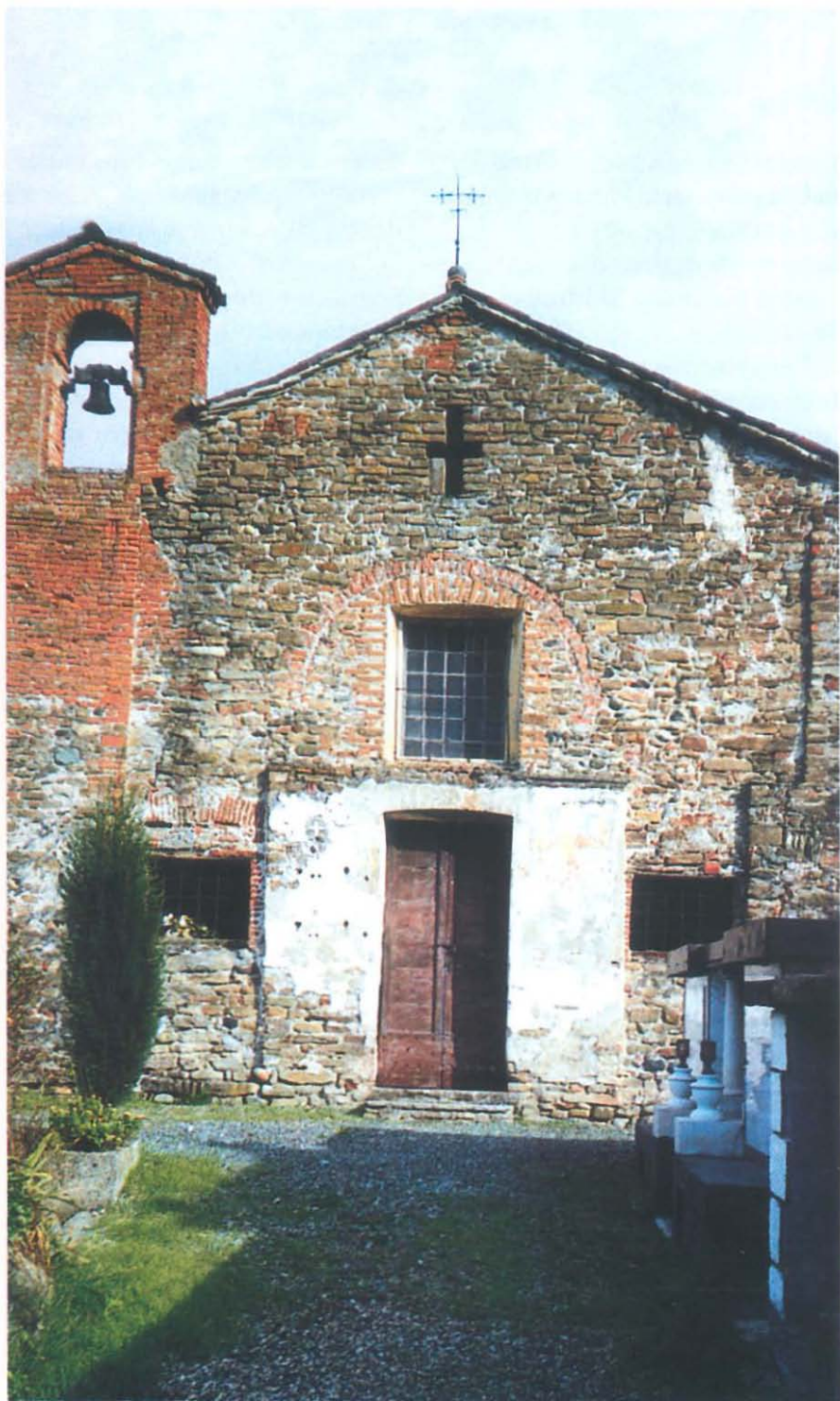
Facciata e campanile (muratura mista che alterna ciottoli di fiume a pietre squadrate e file di mattoni)
