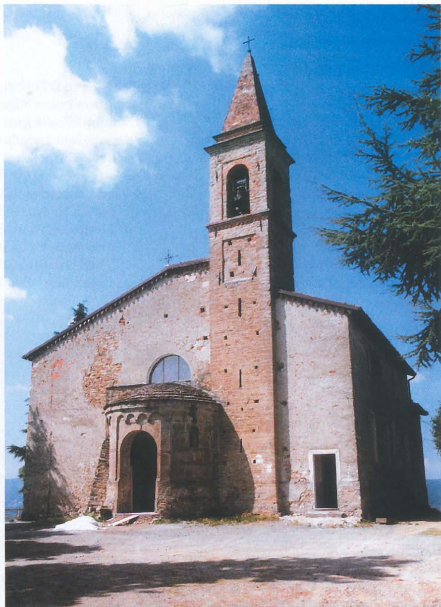
Facciata, campanile e tetto a due falde non simmetriche
