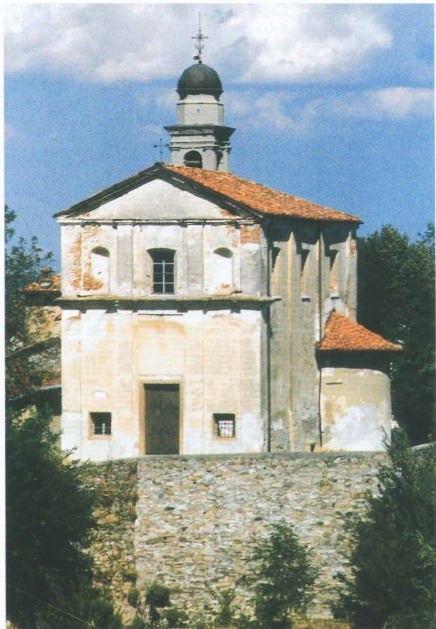
Facciata e parete laterale destra con piccola absidiola
