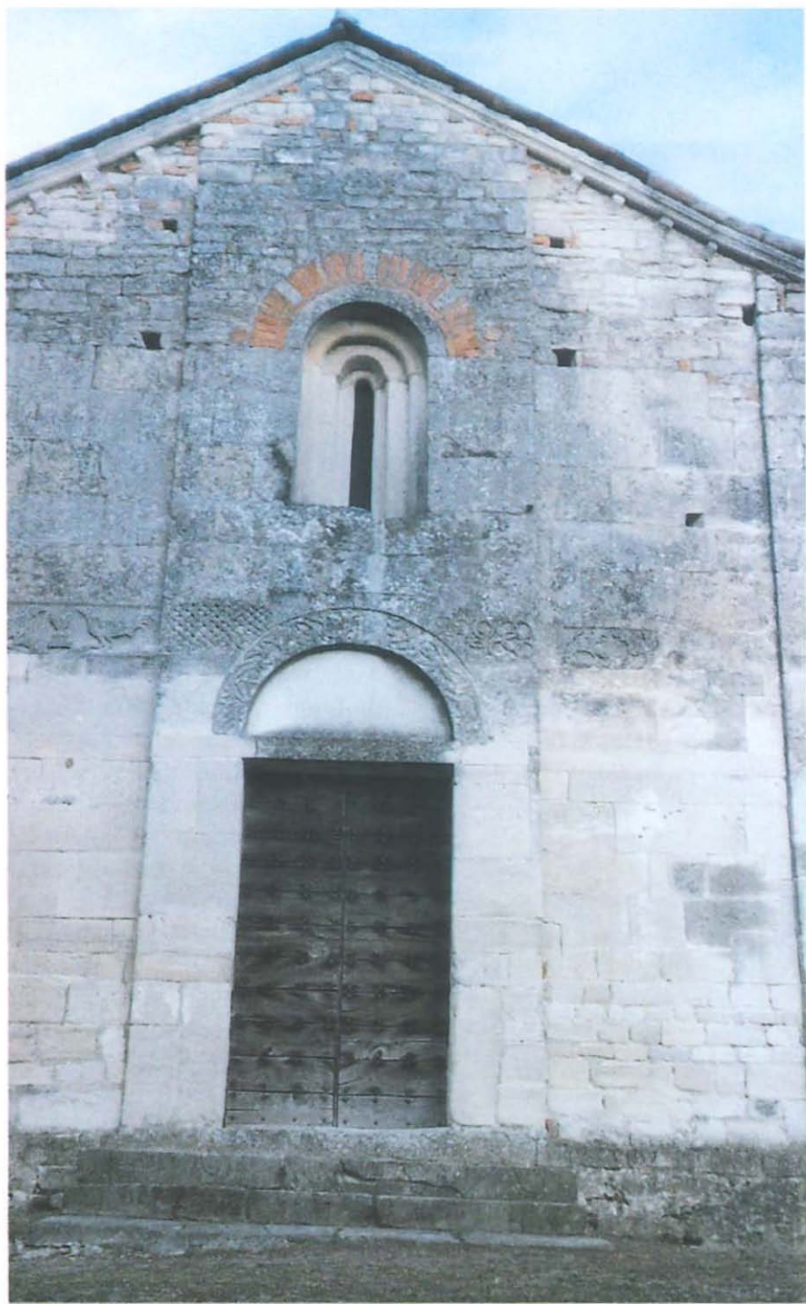
Facciata (conci calcarei alternati a file di mattoni)
