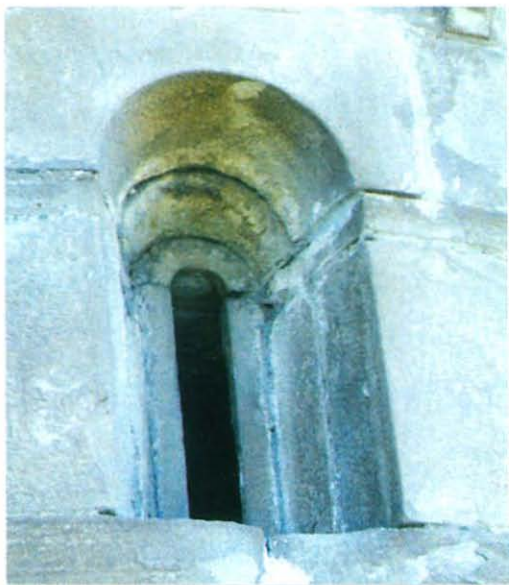
Piccola monofora con architrave e stipiti monolitici
