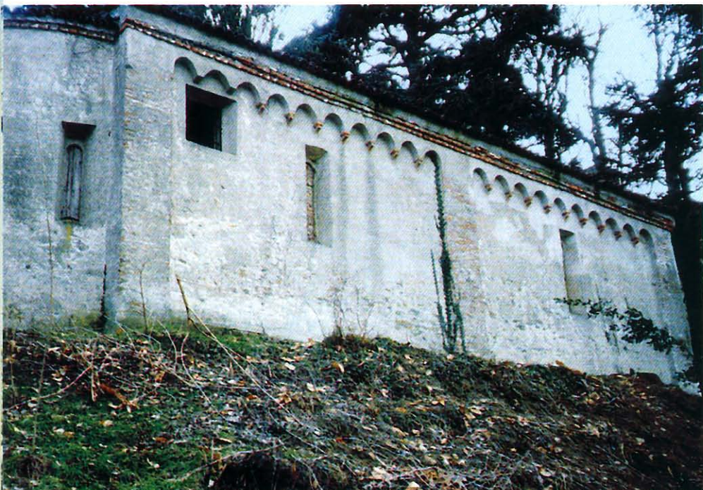
Prospetto nord (Monofore murate, archetti pensili, cornici di mattoni a "denti di sega")
