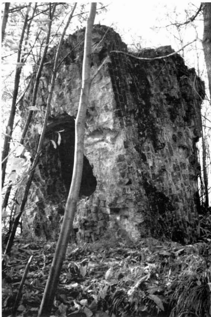
A lato, Morbello, troncone basale della torre, visto da sud-est
